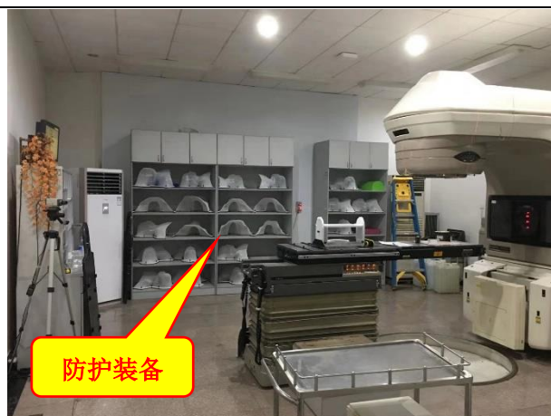
直线加速器机房（2）原貌
