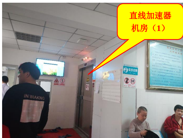
直线加速器机房（1）
