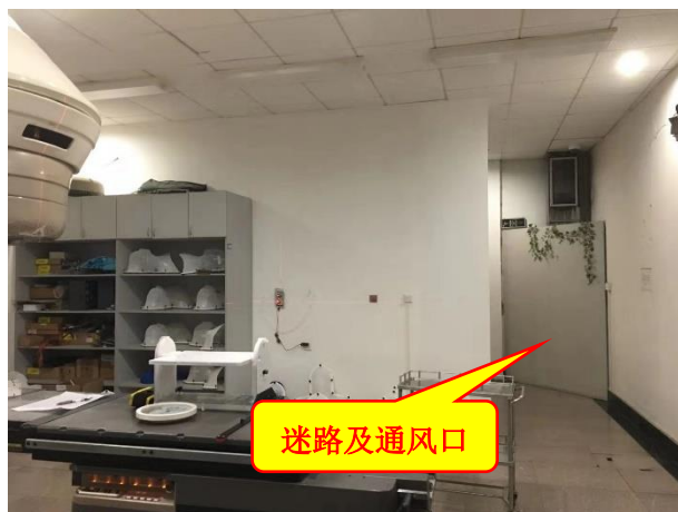
直线加速器机房（2）原貌
