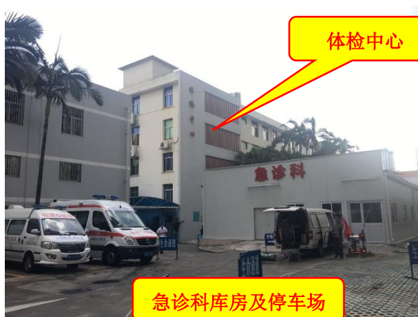
西侧体检中心、急诊科库房、停车场
